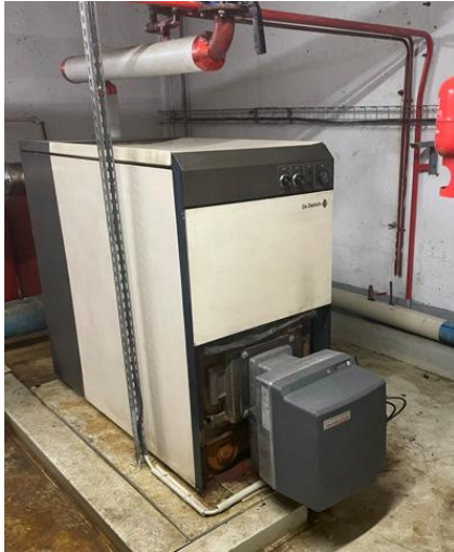
Chaudière concernée par la présence d'amiante
